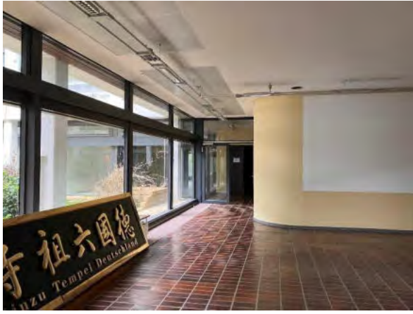
Abbildung 10 Intakte Eingangshalle eines der Hauptgebäude des MPI, Foto: W+G 2023.
