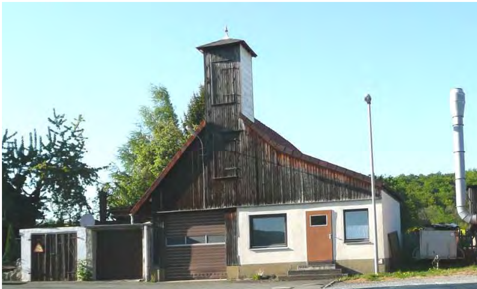
Ehemaliges Spritzenhaus, ebenfalls an der Bergstraße zwischen den Grundstücken Bergstraße 39 und 42. Typische Holzdeckelschalung im Obergeschoß und am Turm erhalten.
