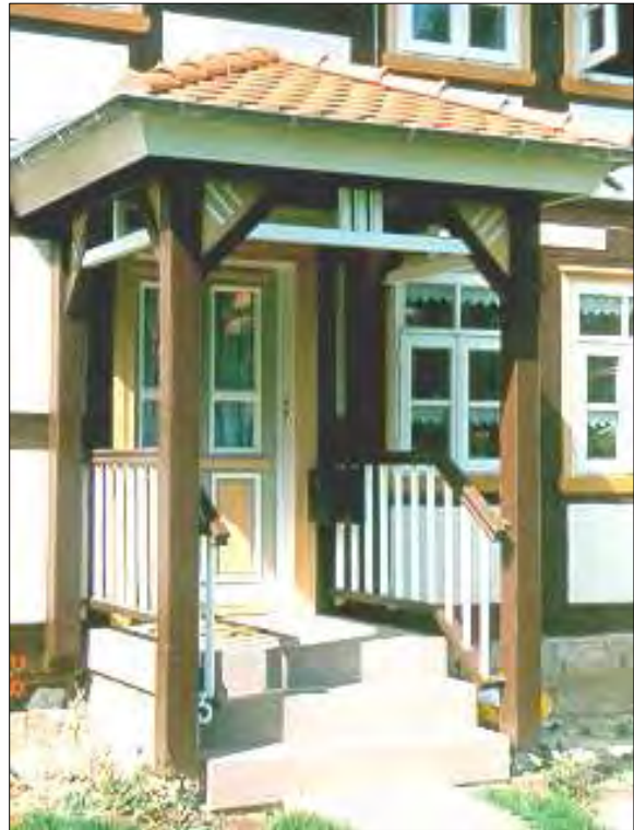
Beispielhafter Vorbau, Geländer und neue Sandstein-Treppenanlage
