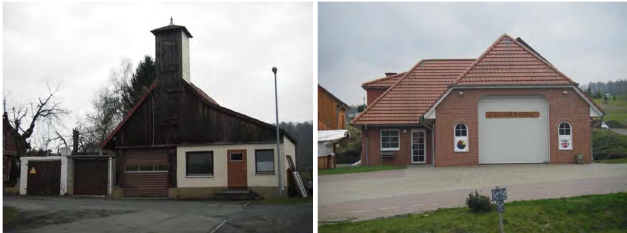
Abbildung 30a und 30b: Das alte Spritzenhaus und das neue Feuerwehrgerätehaus
