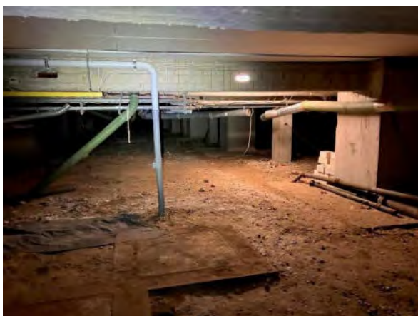
Abbildung 8 Beispiel eines Kellerraumes unter den Hauptgebäuden des MPI, Foto: W+G 2023.
